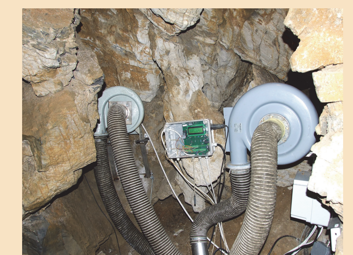
Pokud čidlo naměří vyšší koncentraci plynu, než stanoví norma, sepnou se automaticky odsávací ventilátory, 2022
