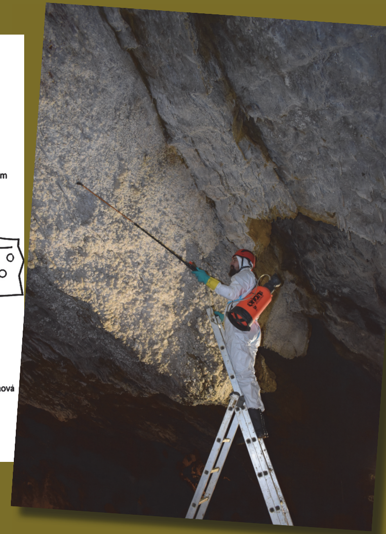
Dnes již standardní sanační postřik Opony se provádí každoročně a mikroklimatu jeskyní neškodí. Today, standard remediation spraying of the Curtain is carried out annually and does not harm the microclimate of the caves.
