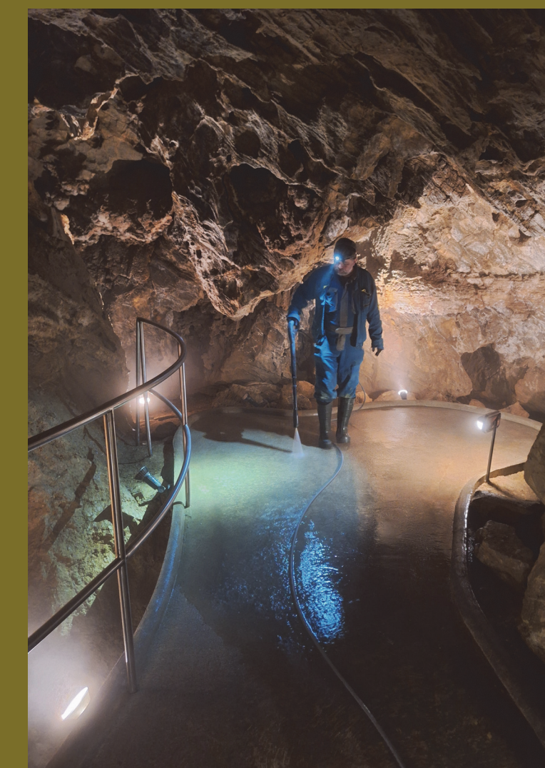
Nečistoty vnesené návštěvníky na betonové chodníky se pravidelně splachují do sběrných jímek. Dirt brought by visitors onto the concrete sidewalks is regularly flushed into collection tanks.
