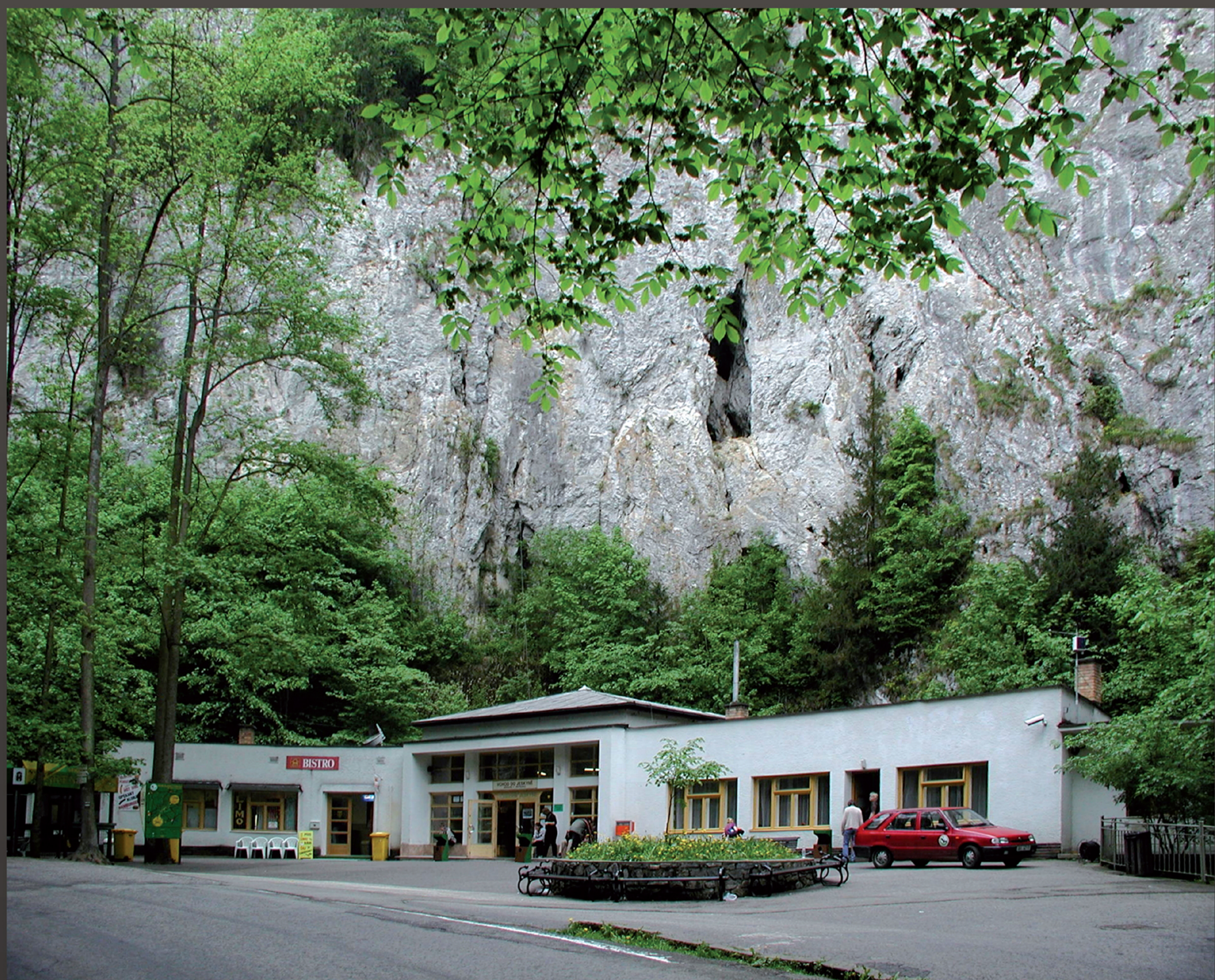
Stará provozní budova z roku 1947 Old entrance building from the year 1947
