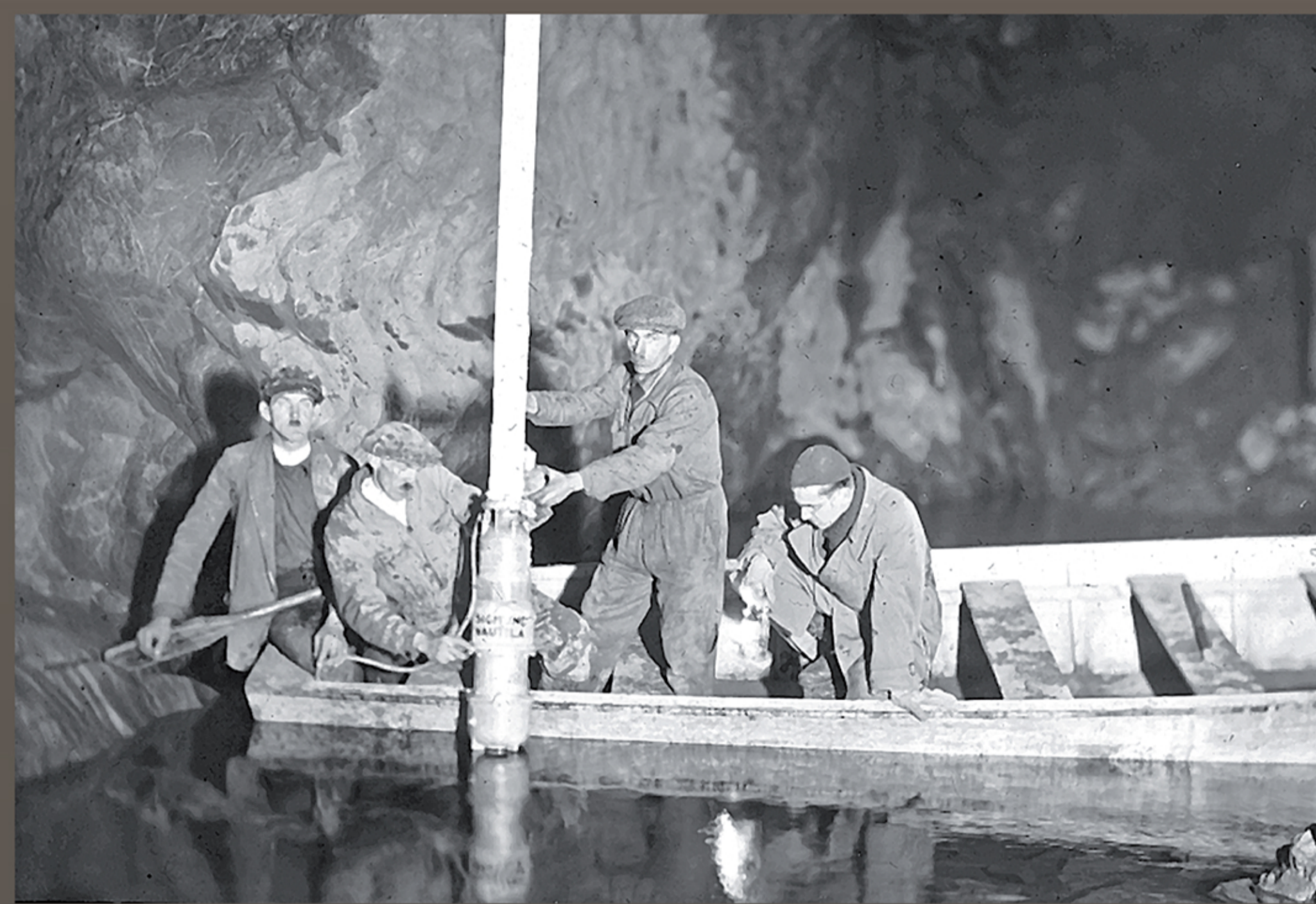
Spuštění čerpadel do Zlého sifonu Putting pumps into the Bad Siphon
