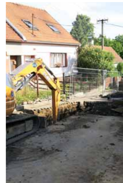
Obr. 4 Budování nové kanalizace v Rudici 2015, foto Roman Šebela
