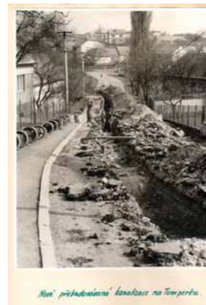
Obr. 3 Budování nové kanalizace v Rudici 1987, archiv obce Rudice
