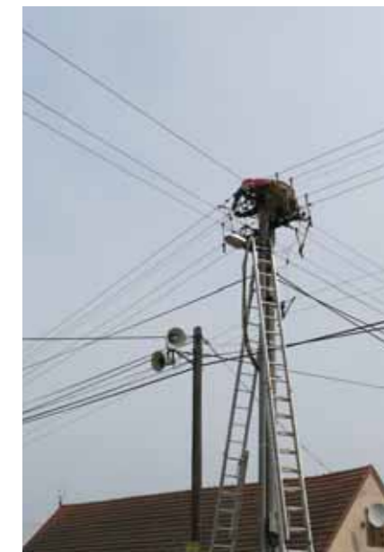
Obr. 5 Kabelizace sítí 2015, foto Roman Šebela
