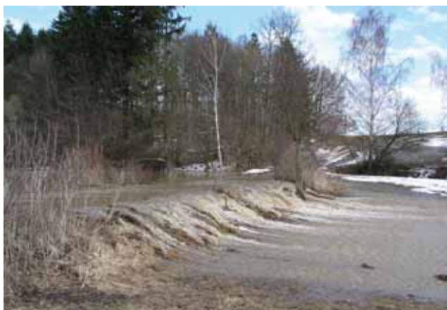
Při prudkém jarním tání nebo příválových deštích dochází v důsledku ucpání silničního propustku na Hořickém potoce k zaplavení okolních luk. Následnou reakcí je pak relativně rychle navýšení průtoku v podzemním toku Chýnovské jeskyně. (Foto: František Krejča, rok 2006)
