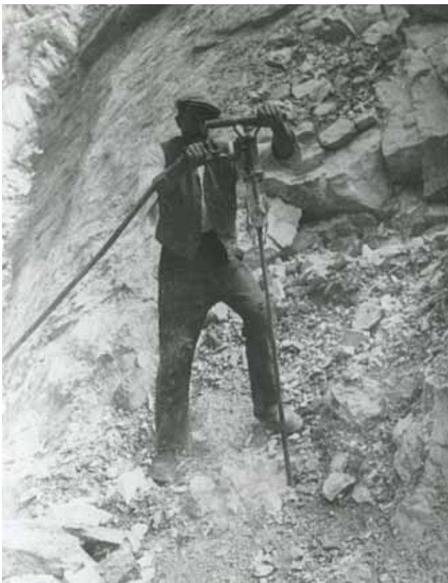
Po roce 1928 bylo v lomech zavedeno pneumatické vrtání. Lom Pacova hora. (Archiv SCHJ)
