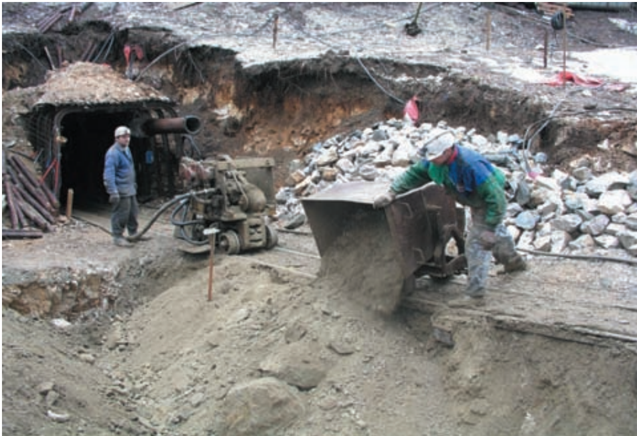
Chýnovská jeskyně, rekonstrukce návštěvní trasy, ražba nové východové štoly. Foto: Archiv SCHJ
