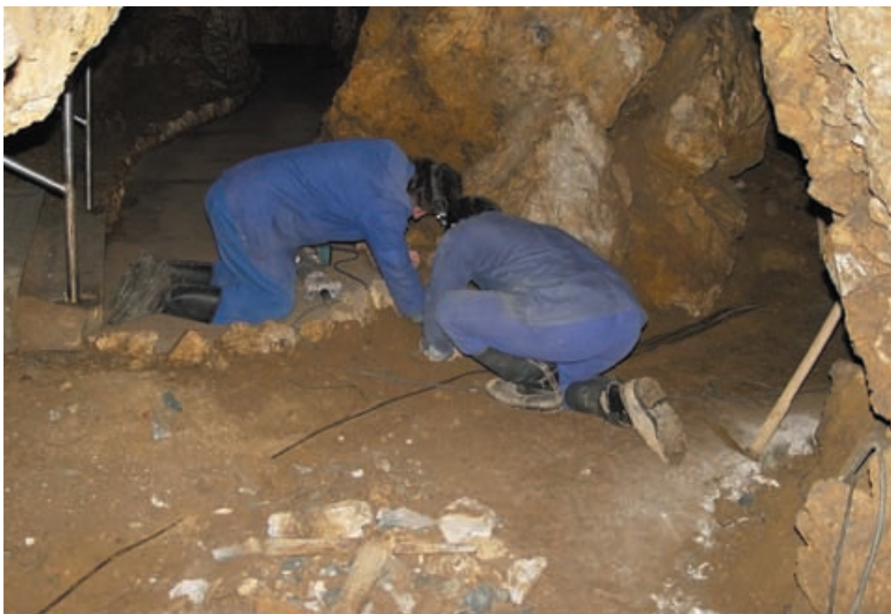
Bozkovské dolomitové jeskyně, úprava lemů chodníků v Blátivé chodbě. Foto: Dušan Milka
